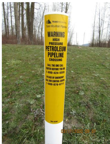
Balise d'une emprise
